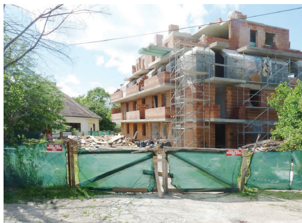
Épülő társasház az újtelepi óvoda mellett
