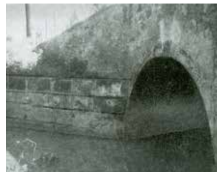
Robbantás után újjáépítve
