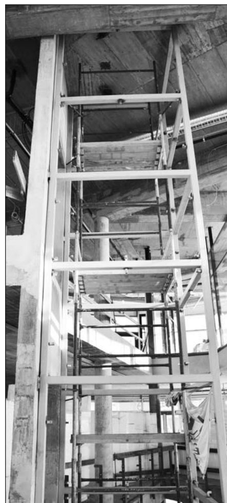
Megtörténtek az előkészületek a látványlift gépészeti részének fogadására.
