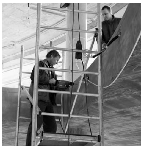
A központi rész második szintjén a közösségi tér korlátelemeinek elhelyezése, rögzítése történik.
