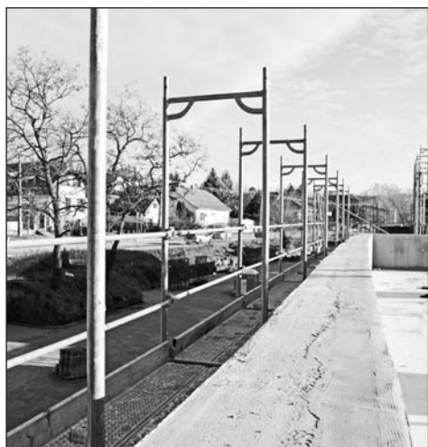
A mellvédfal előkészítése megtörtént a műkö-burkolat fogadására.
