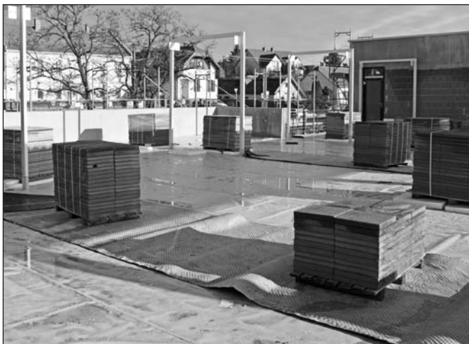
Járhatótető burkoló lapjainak beszállítása megtörtént.
