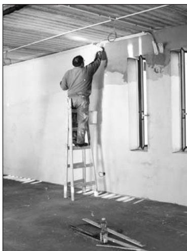
Megkezdődtek a belső festéselőkészítési munkálatok.
