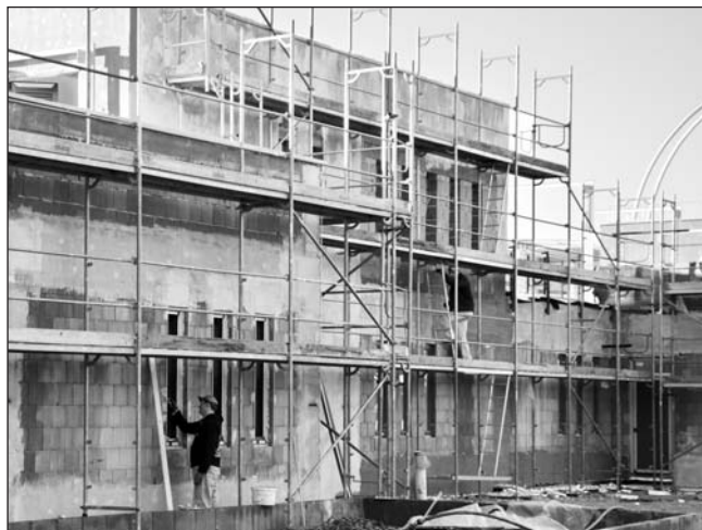
Elkészültek a homlokzati állványok a külső vakoló és burkoló munkákhoz.
