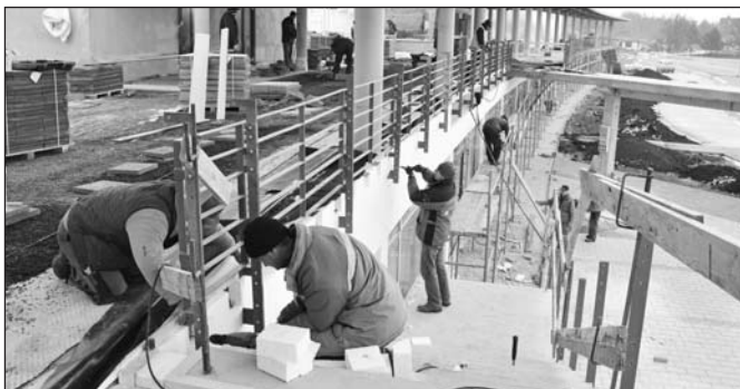
Az épület tő felőli homlokzatának hőszigetelési munkáinak végzését látjuk.
