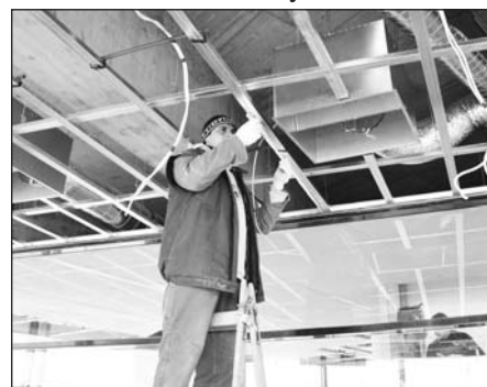
Folyamatban van a díszterem légtechnikájának kiépítése.
