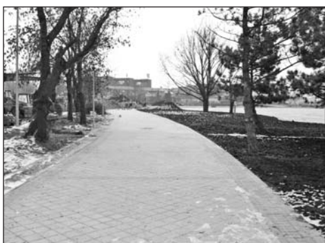
Az elkészült sétány szakaszt látjuk az IFI ház felől, mellette kiépítésre került a térvilágítás is.
