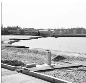
Elkészültek a homokos strand közlekedő járdái, illetve a zuhanyzó létesítmények.
