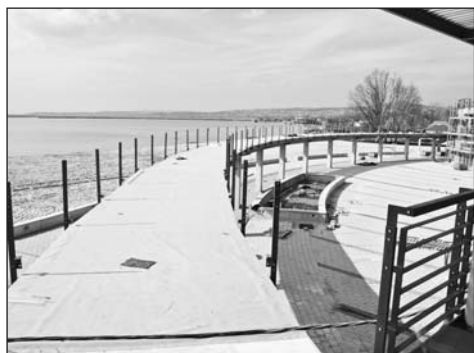
Megkezdődtek a kollonád járhatóvá tételének burkolás előkészítő, illetve korlát szerelési munkái.
