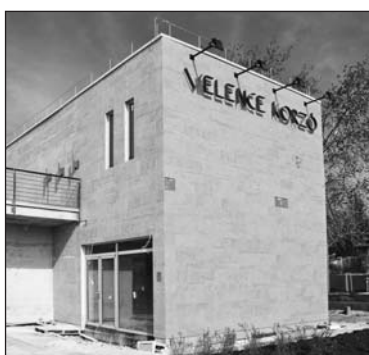
Az elkészült homlokzati burkolás végső arculata.
