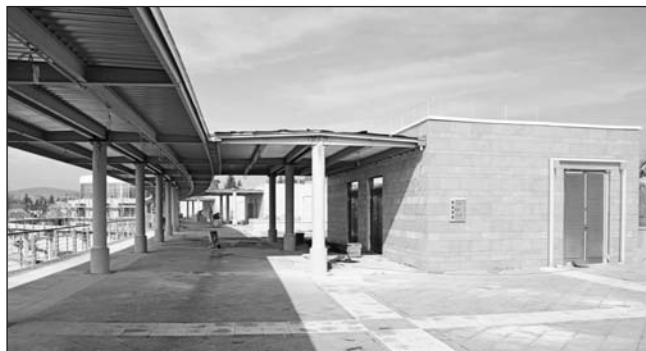
Elkészült a járható tetőburkolat.
