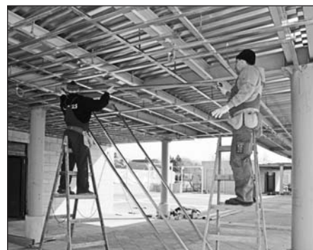
Készül a pilltető szerkezet alsó burkolatának fogadó része.
