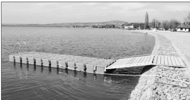
Kihelyezésre került a tervezett úszóstég.
