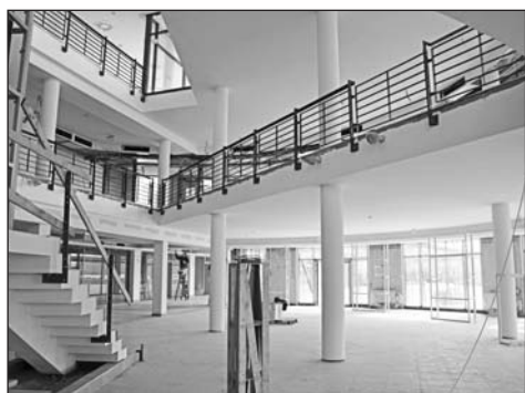
A központi tér lépcsőburkolata illetve korlát-felszerelési munkái többségében elkészültek.
