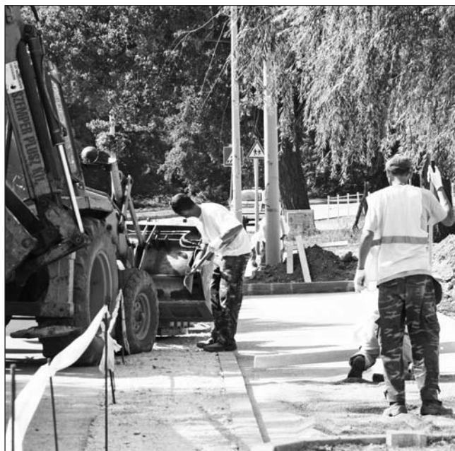
A kiépített szegélyek között megfelelő alapozást követően a térkő burkolatok fektetése történik.
