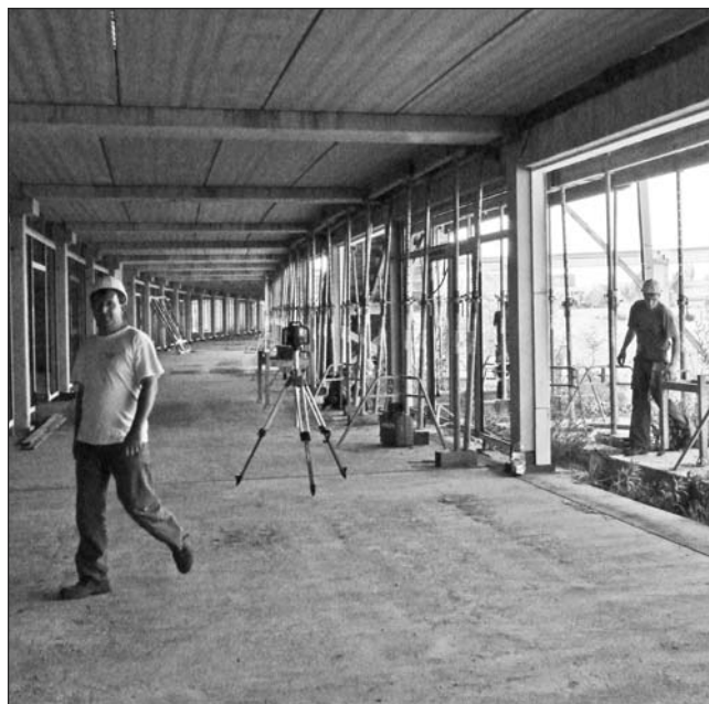
A korzó épület belső szintezési munkái elkészültek, az alátámasztó állványzat teljes körű felülvizsgálata és kibiztosítása elkészült.
