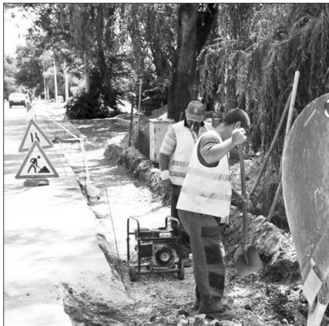
A Tóparti úttal párhuzamos parkolók kiépítéséhez szükséges az előkészítő földmunka végzése.
