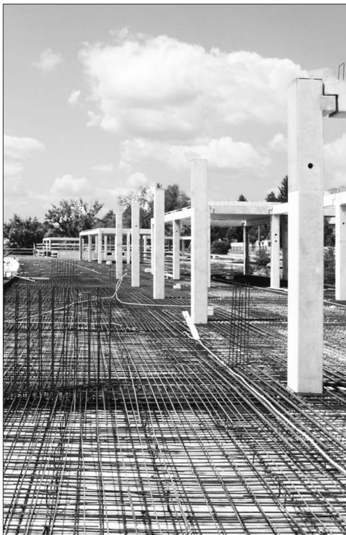
Elkészült az első szint záró betonjának teljes vasalása.
