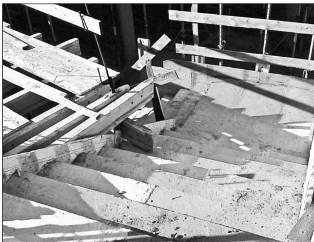
A létesítmény több belső lépcső szerkezete is kiöntésre került.
