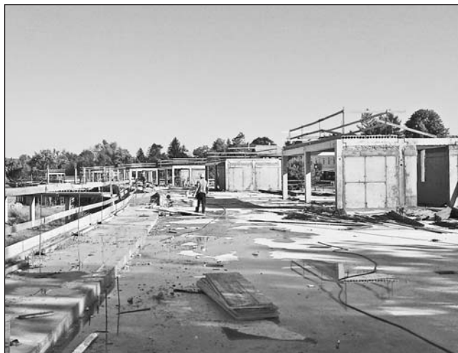
A második szint létesítményeinek a terv szerinti statikai funkciójú vasbetonfal elemei megvalósultak.
