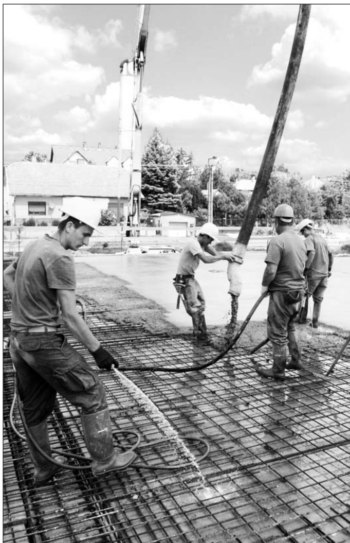
A földem betonozás folyamatát láthatjuk.
