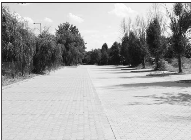
Jelentős az előrehaladás a belső szervíz út és parkoló burkolat készítését illetően.
