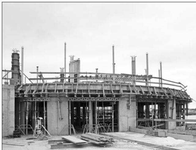
Elkezdődtek a rendezvényter tartószerkezet elhelyezés munkálatai.
