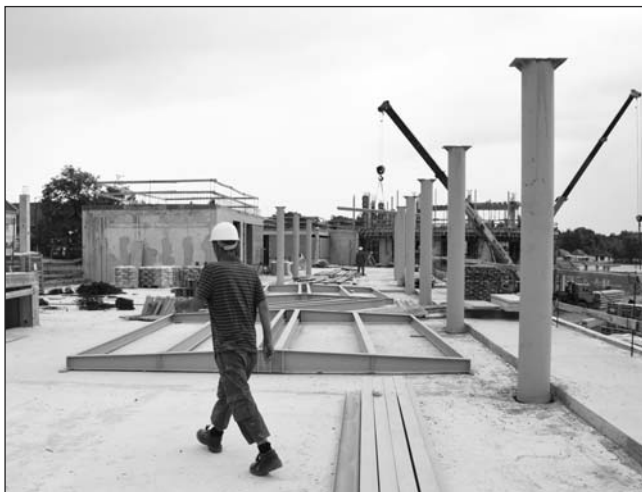
Folynak az acél pilletető szerelési munkálatai.
