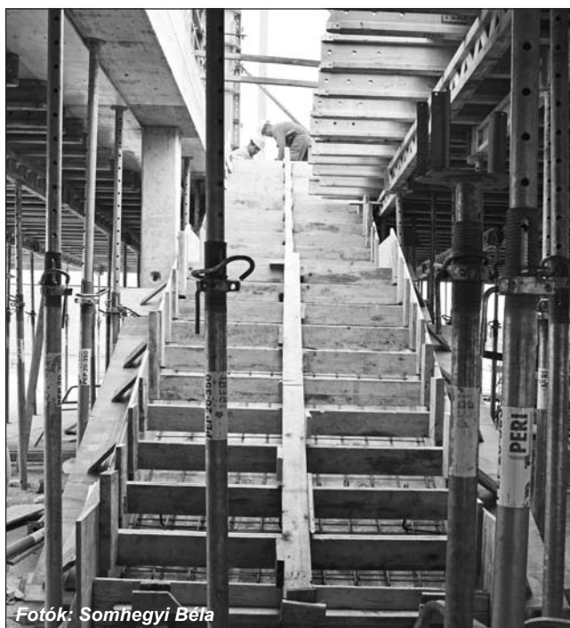
Készül a központi térből a rendezvény teremhez vezető lépcső zsaluzása.
