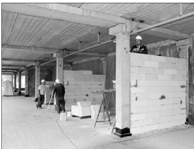
Megkezdődött a szolgáltató egységek határoló falainak építése.
