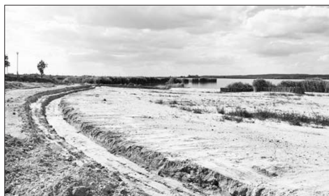
Megkezdődött a tervezett sétány mellé telepítendő ülőpad alapozása
