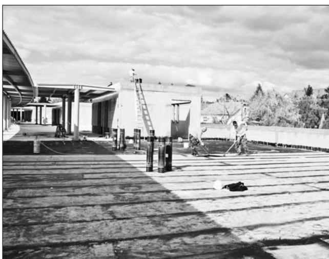
Folynak a lapos tető alsó párazáró szigetelési munkálatai.
