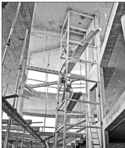
Készül a belső liftakna
