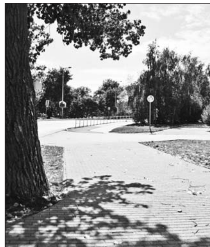
Elkészült a projekt első közlekedési kapcsolatát biztosító térburkolat
