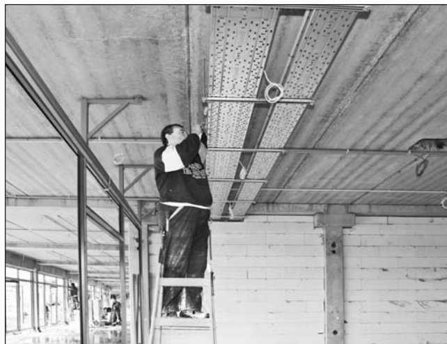
Folynak a villanszerelő kábelvezetési munkálatok.
