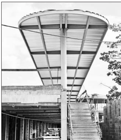
Elkészült a pilletető trapézlemez borítása a teljes felületen.
