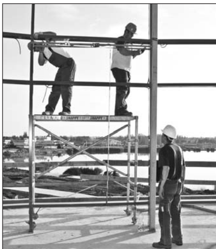
A díszterem üvegezett határoló-szerkezetének munkálatait láthatjuk.
