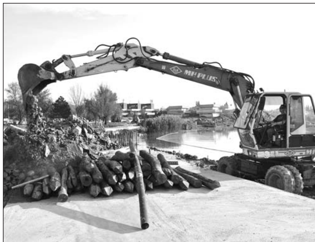
A kijelölt szakaszon folynak a partfalépítés előkészítő munkái.
