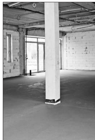
Ilyen a már kész aljzatbeton.
