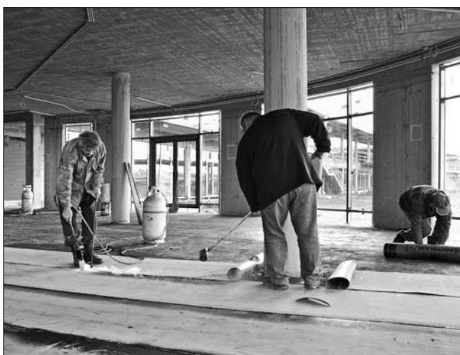
Elkezdődtek az épület aljzatbetonozásának előkészítő munkái. Folynak a szigetelő munkák.
