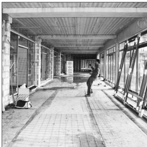
A vízszigetelésre terített hőszigetelés, illetve vasalat előkészítés van folyamatban.
