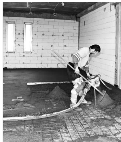
Készül a belső tér kiegyenlítő betonozása a burkolat alá.
