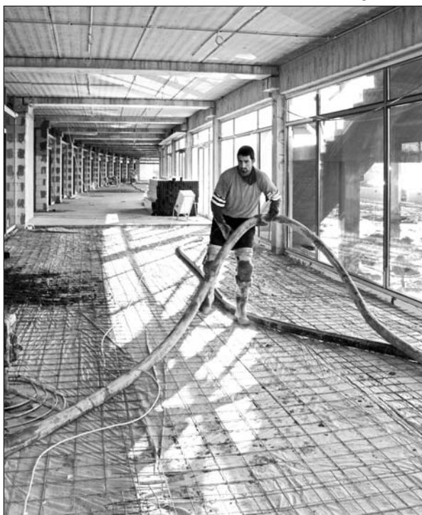
Készül a belső tér kiegyenlítő betonozása a folyosó térben.
