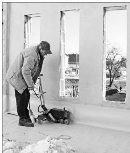
A tető pvc szigetelés munkái folynak.
