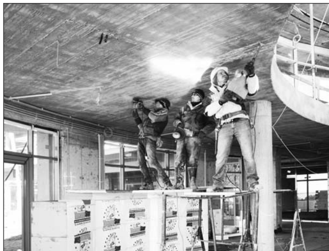
Folynak a födémvakolás előkészítő munkálatai.
