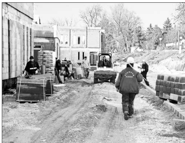
Elkészült a szervízút alapozása, a burkolat következik.
