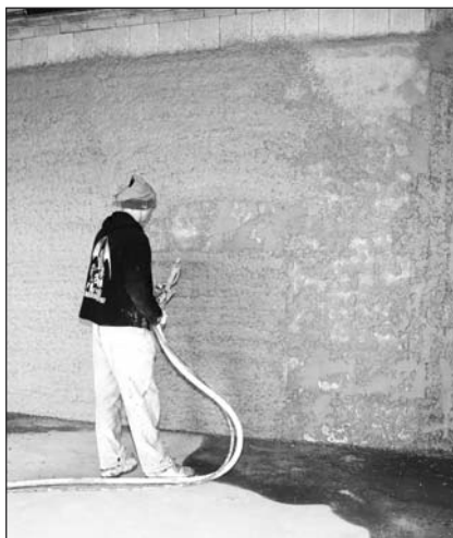
Megkezdődtek a belső vakolási munkák.
