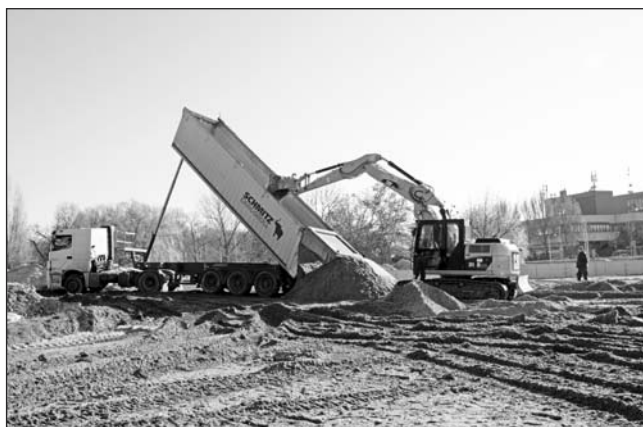
A homokos strand rétegelt felületének anyagbeszállítási munkái folynak.
