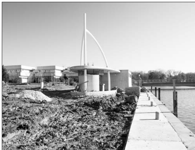
Kikötő jelzőfény kábelezési munkái
