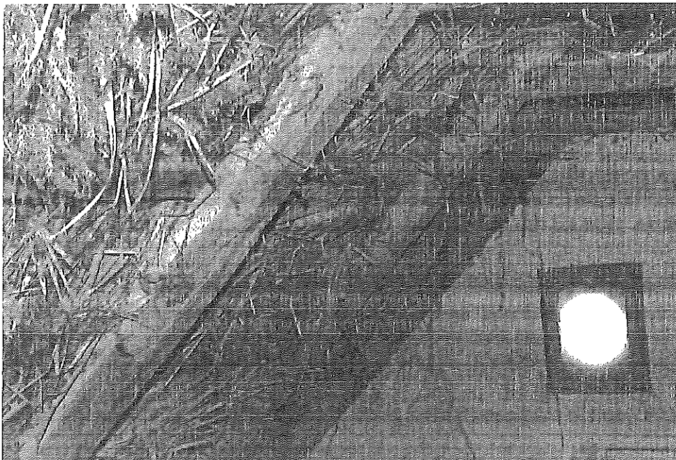
12. A tetőszerkezet, hasított, bárdolt felületű faelemek
