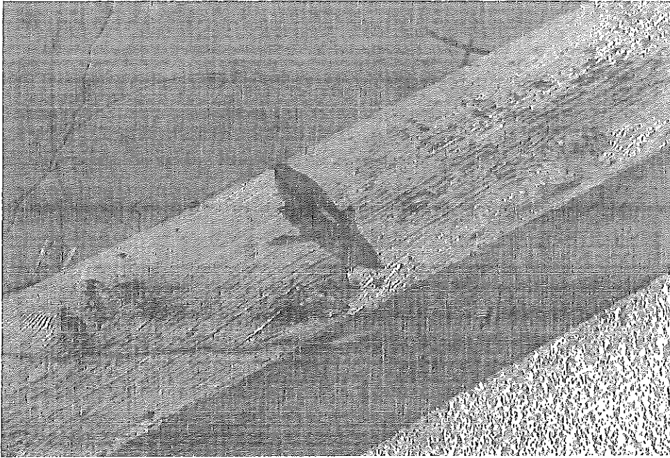
3. A tetőszegély egyik kovácsolt rögzítő-feszítőeleme az utcai homlokzaton (bal oldal)
