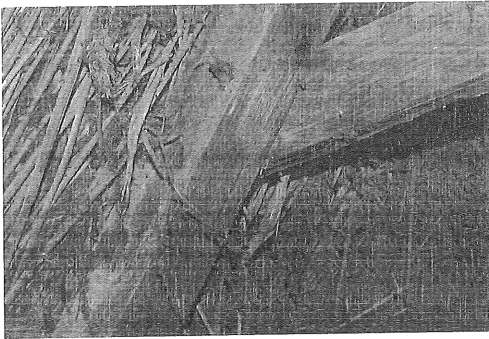
13. Tetőszerkezet, faszeges rögzítés
